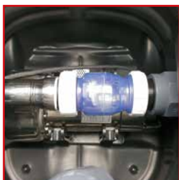
Spiatocňný ventil RSK a vypúšťacie čerpadlo
